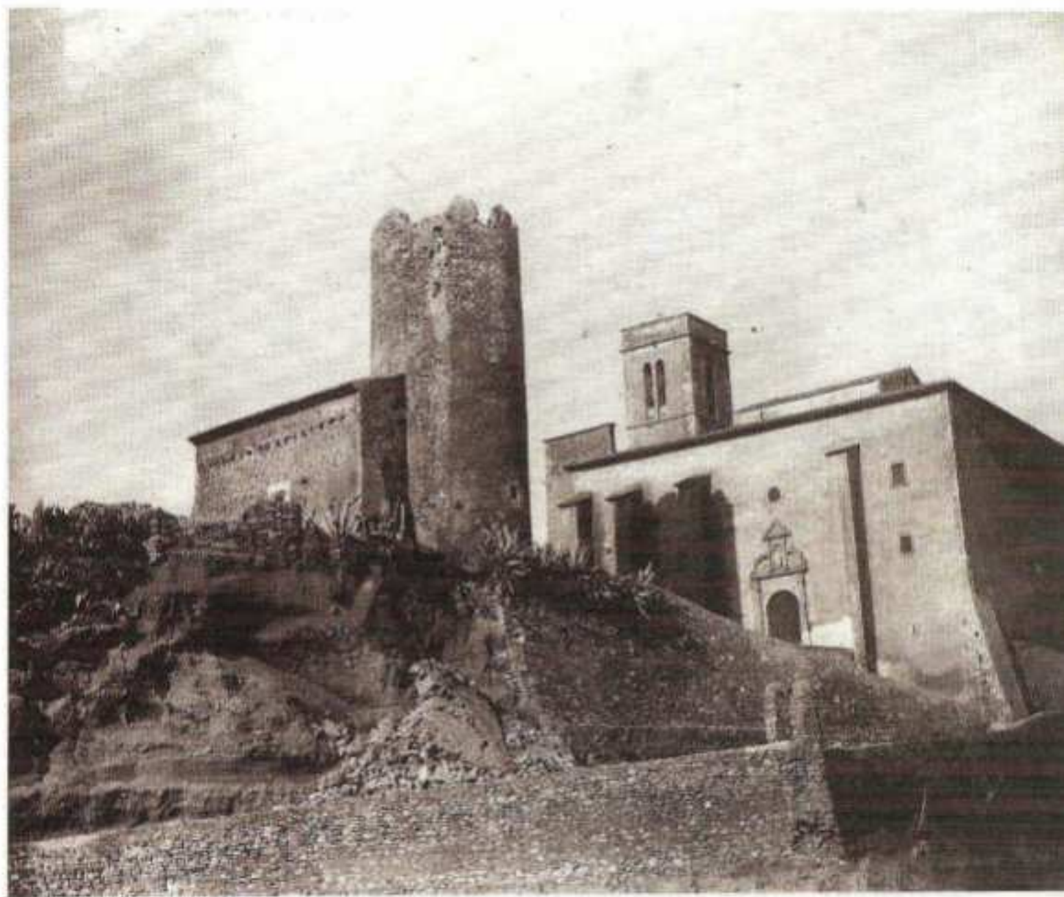
El conjunt format pel Castell de Ribes i l'Església Vella, construïda al segle XVII. La imatge mostra una part de paret arruïnada l'any 1898, que després es va reconstruir.
