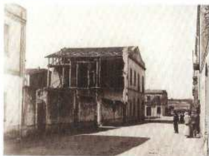
Any 1896. El Centre Recreatiu o Casino de Ribes durant les obres de reconstrucció d'un dels laterals. Es va inaugurar el 1883 i més tard va obrir també una sala a l'aire lliure: el Tivoli.
