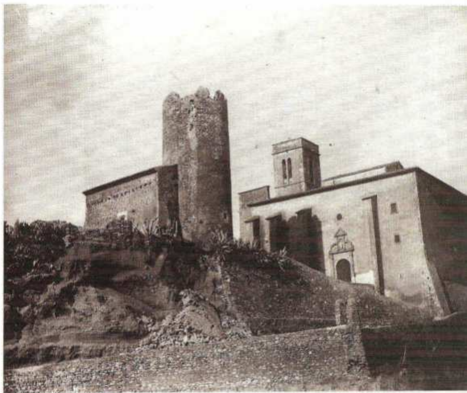
El conjunt format pel Castell de Ribes i l'Església Vella, construïda al segle XVII. La imatge mostra una part de paret encunada l'any 1898, que després es va reconstruir.
